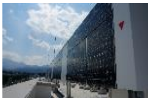
太陽光パネル
