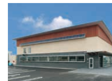
会津データセンター
