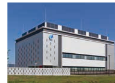
福島データセンター
