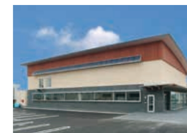
会津データセンター
