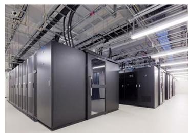
水冷式空調を採用しホットアイルを完全密閉したモジュール型ラックを採用
